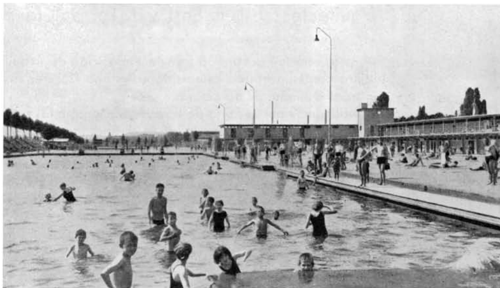
Piscina en Stuttgart. - Paul Bonatz y F. E. Scholev, Arquitectos
