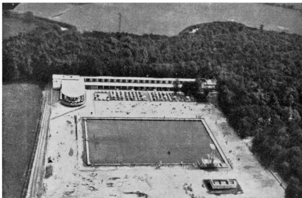
Piscina en Leuna - Kurt Jahn, Arquitecto
